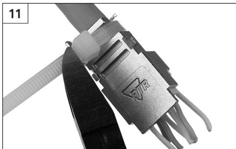
Kabelbinder zur Zugentlastung anbringen und Überlänge entsprechend abschneiden.
