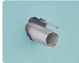
**1** Abluftleitung und Netzanschluss werden an der späteren Montageposition von ELS platziert.
