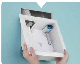
**3** Der praktische Vorwandadapter ELS-VA wird nun montiert. Abluftleitung und Netzleitung werden am ELS-Gehäuse angeschlossen. Anschließend wird das Gehäuse einfach eingeschoben. Praktisch: der mitgelieferte Putzdeckel schützt vor Verschmutzung.
