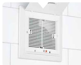
**6** Abschließend wird die Fassadenblende mit Hilfe des Ausgleichsrahmens ELS-AGR montiert und der Dauerfilter eingelegt.
