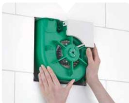
**5** Im Zuge der finalen Arbeiten im Raum wird der Ventilator-Einsatz einfach eingeschoben – und rastet hörbar ein.
