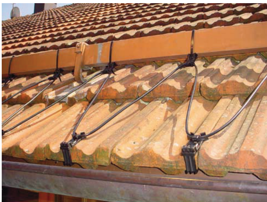
Die DEVIdclip™ Schutzgitterhaken (Best. Nr. 19-805193) ermöglichen eine "Zick-Zack" Montage der Heizleitung
