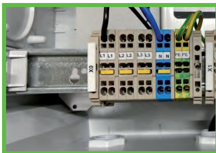
Abb. 14 A: 230V Anschluss PURE
